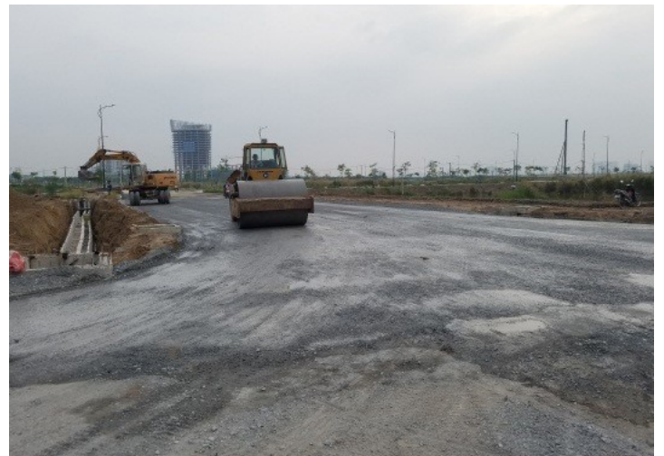
BT Thủ Thiêm: Thi công đường N7
