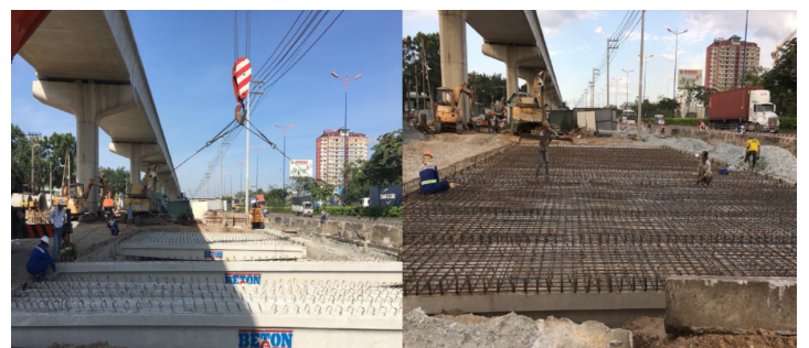
XLHN: Thi công đổ bê, thân, sàn giảm tải mố cầu vượt đường song hành hai bên
