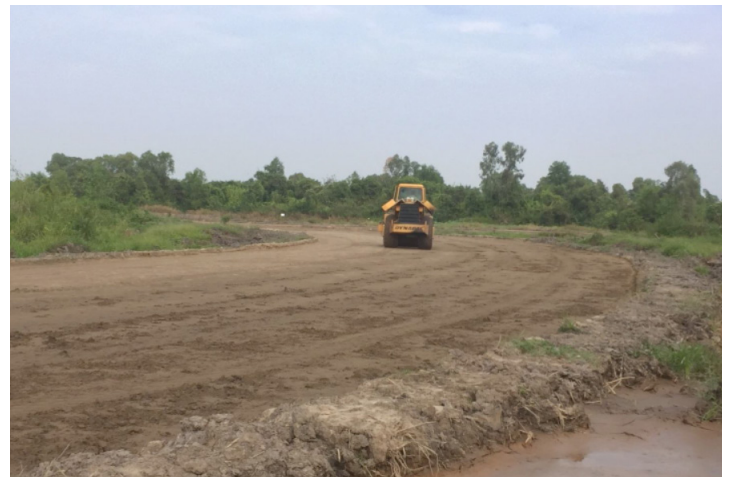
TL-MT: Thi công lu lèn đường nhánh N2
