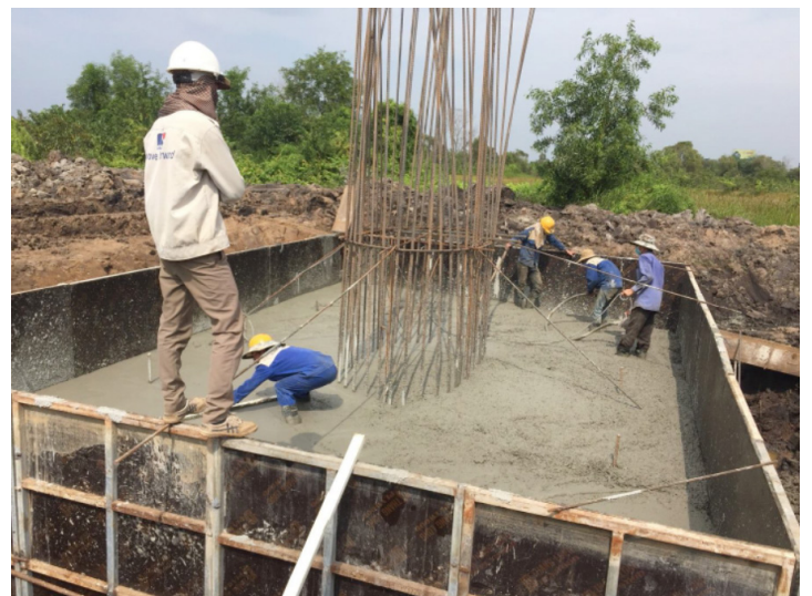
TL-MT: Thi công đổ bê tông bộ trụ cầu
