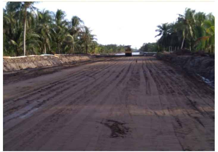
QL60: Lu lèn cát nền đường phần tuyến đoạn Mỏ Cày - Bến Tre
