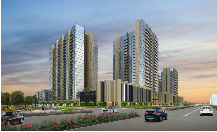
Phối cảnh dự án nhìn từ Đại lộ Vòng Cung
