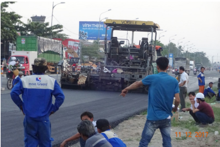
QL60: Trải thảm nhựa đoạn qua huyện Châu Thành - Bến Tre
