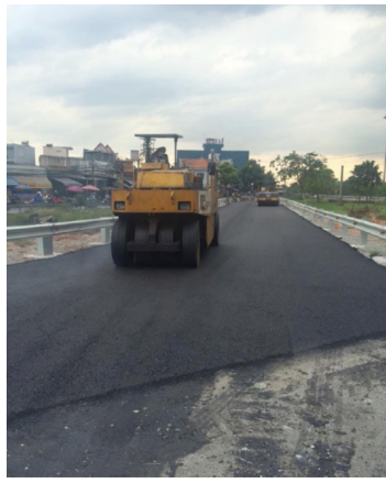
XLHN: Thi công trải bê tông trải nhựa các nhánh tạm để chuẩn bị đào hầm chui đoạn qua nút giao ĐHQG
